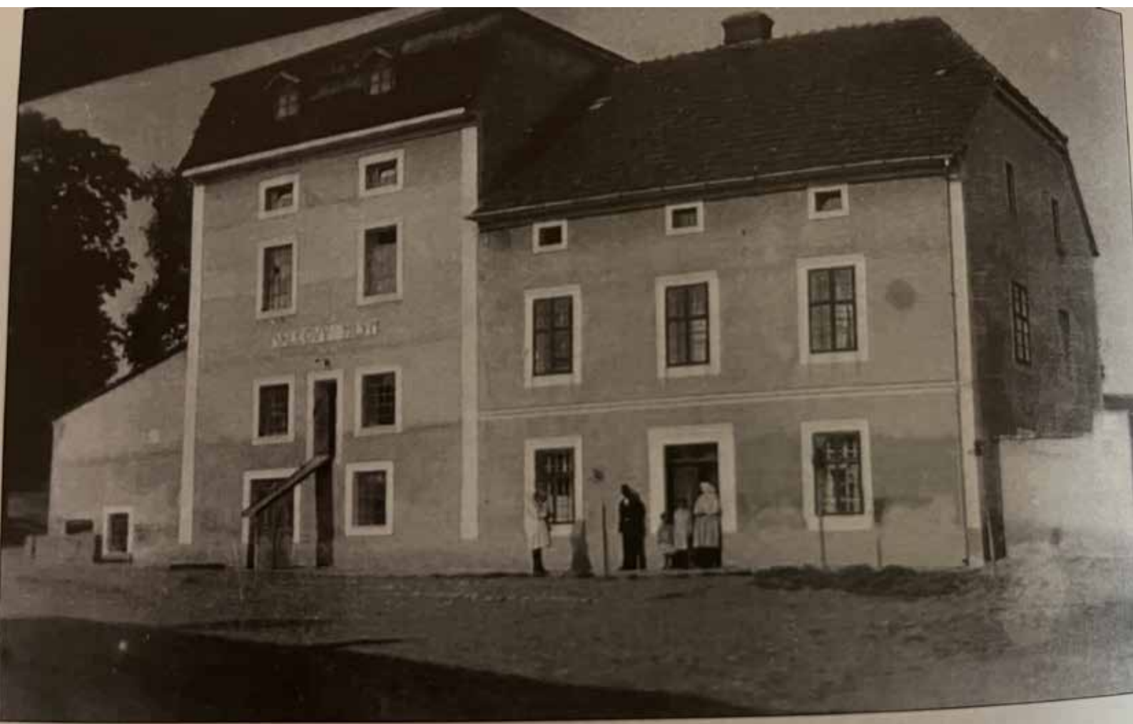
Zrekonstruovaný mlýn po požáru, 1935.
