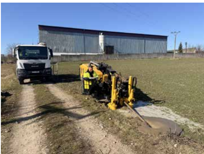
Realizace rozvodů VO a HDPE v lokalitě Zahumny - bezvýkopová metoda
