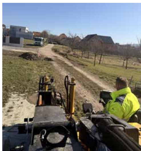
Realizace rozvodů VO a HDPE v lokalitě Zahumny - bezvýkopová metoda
